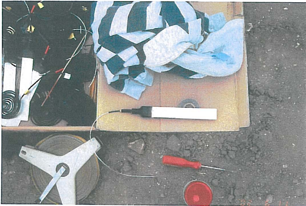
Bild 6: Spannungsgeber (Bildmitte) vor der Installation
