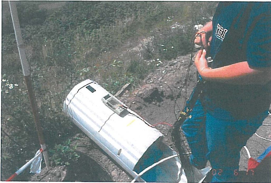
Bild 7: Funktionsprüfung der Einzelkabel vor dem Einziehen des Kabelstranges in die Kontrollbox (liegend)
